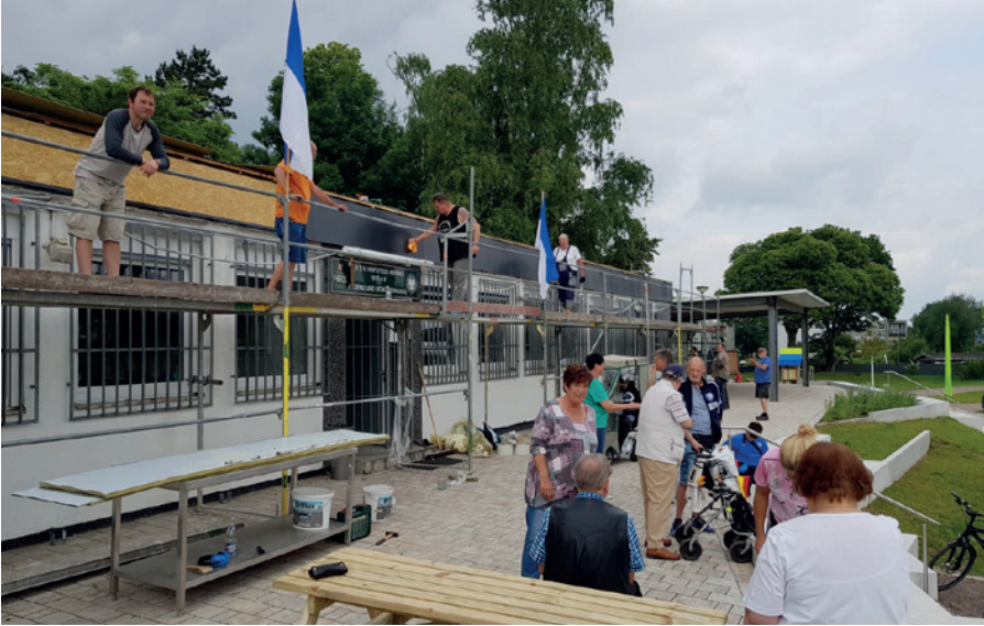
Arbeiten am Schützenhaus im Rahmen der Sanierung
